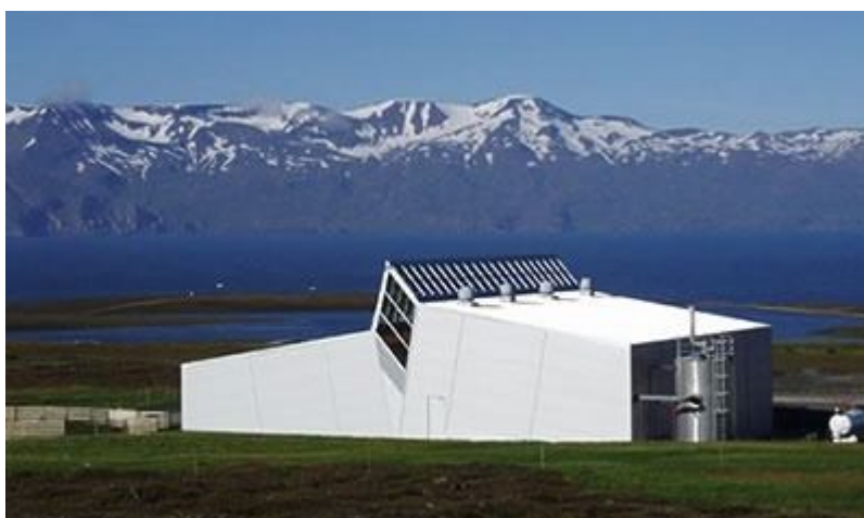
Слика 31: Бинарна геотермална електрана са Калина циклусом Húsavík снаге 2 MW на Исланду
