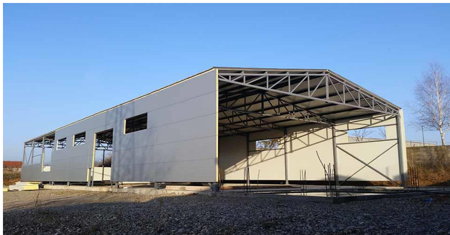
Слика 1.2. Метална хала [11]
