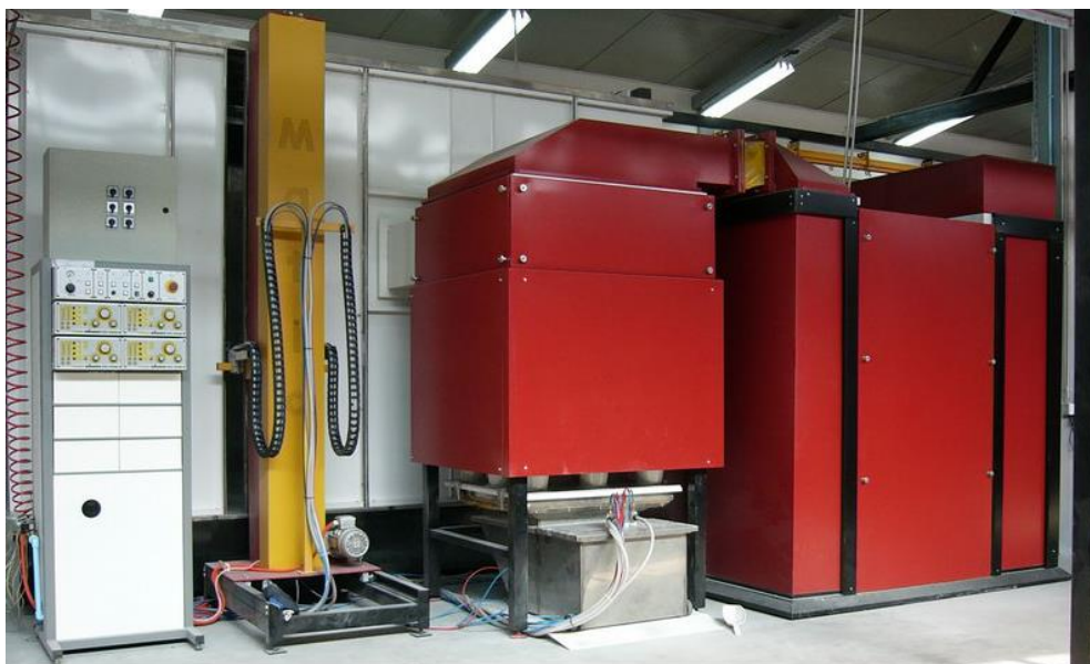
Слика 4.15: Комора са конвејером
