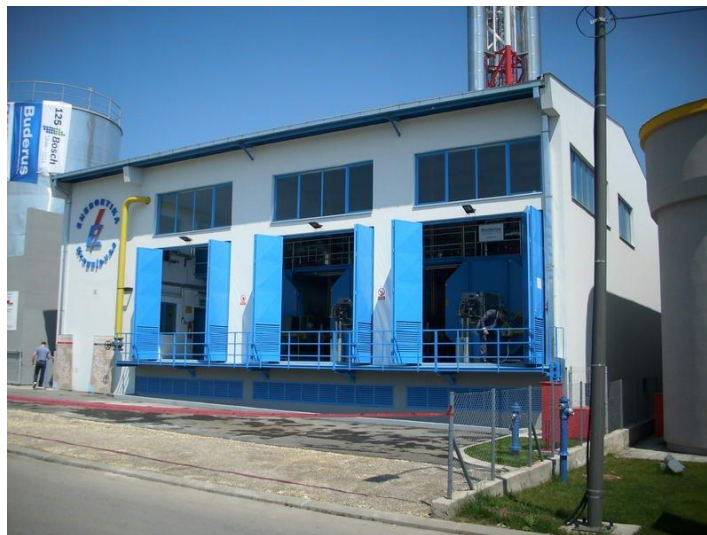
Слика 5.22 – Котларница Аеродром [15]
