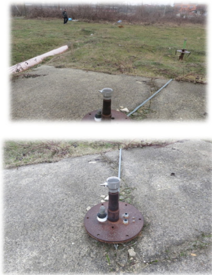
Слика 20. Приказ позиције цевовода. Близина шахта у коме би се остварила хидрауличка кратка веза за затворени систем коришћења пасивног система хлађења цевовода
