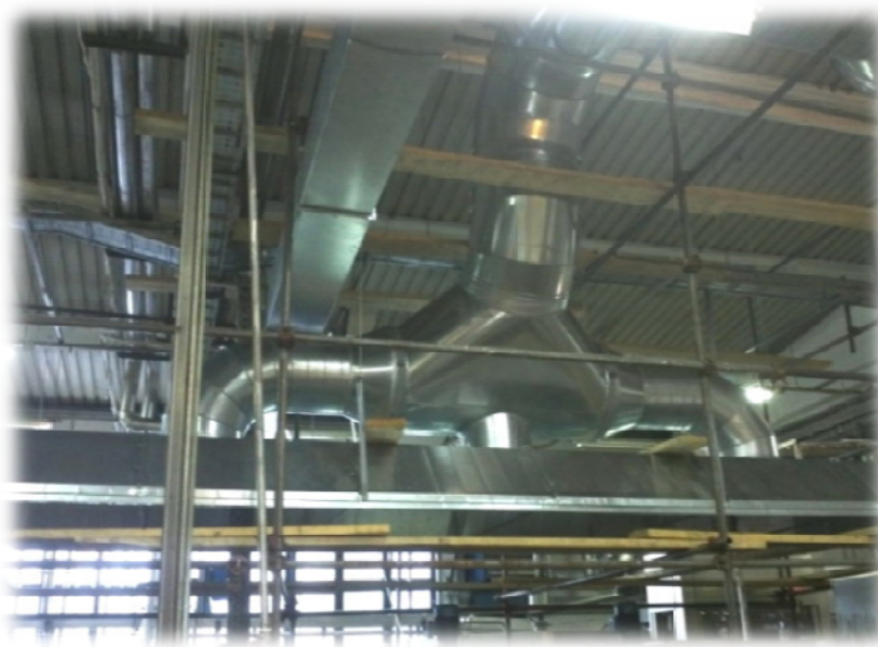
Слика 17. Приказ дела производне хале са позицијама одсисних хауба
