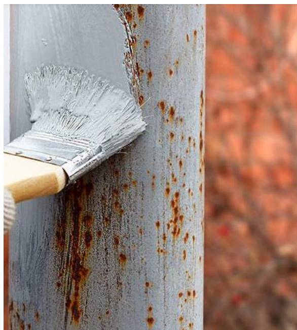
Слика 2.1 Пример рђе која се налази на цеву која је изложена временским променама [2]
