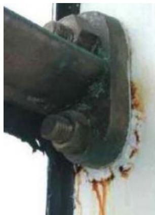
Слика 2.6 Контактна (галванска) корозија [5]
