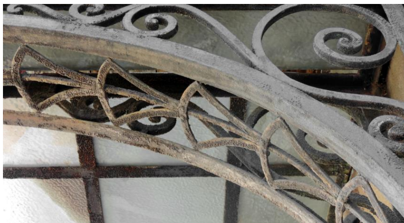
Слика 2.3 Метална ограда коју треба претходно очистити од прашине да би се нанела заштитна и декоративна превлака [4]
