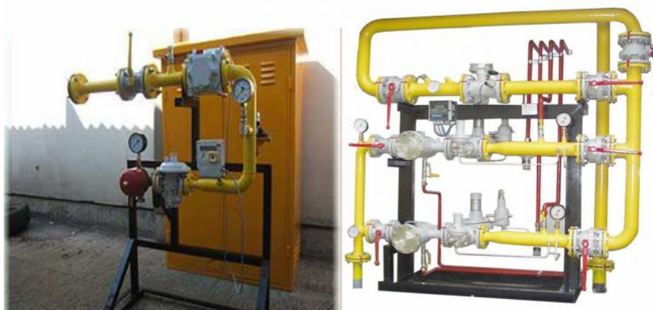
Слика 13.4 Пример једнолинијске (лево) и вишелинијске (десно) станице
