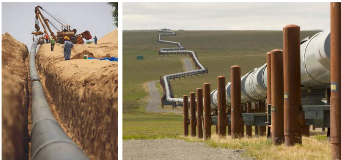
Слика 10.1 Магистрални цевовод, а) подземни б) надземни
