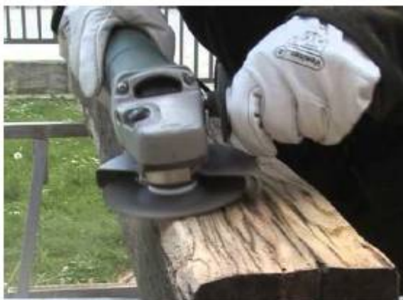
Слика 3.5 Приказ машинског чишћења површина [10]
