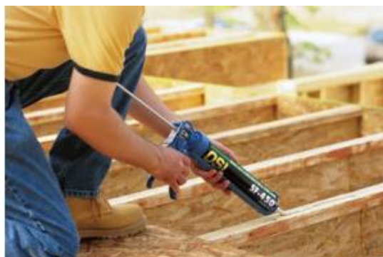
Слика 5.7 Наношење лепка за спајање панела и дрвета [19]
