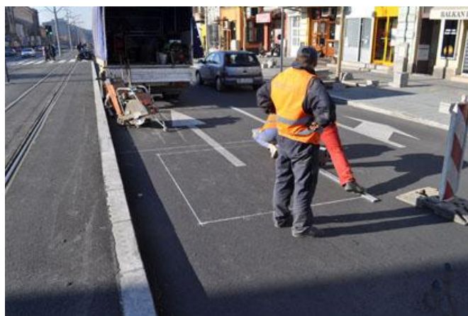
Слика 12. Детаљ постављања индуктивне детекторске петље
