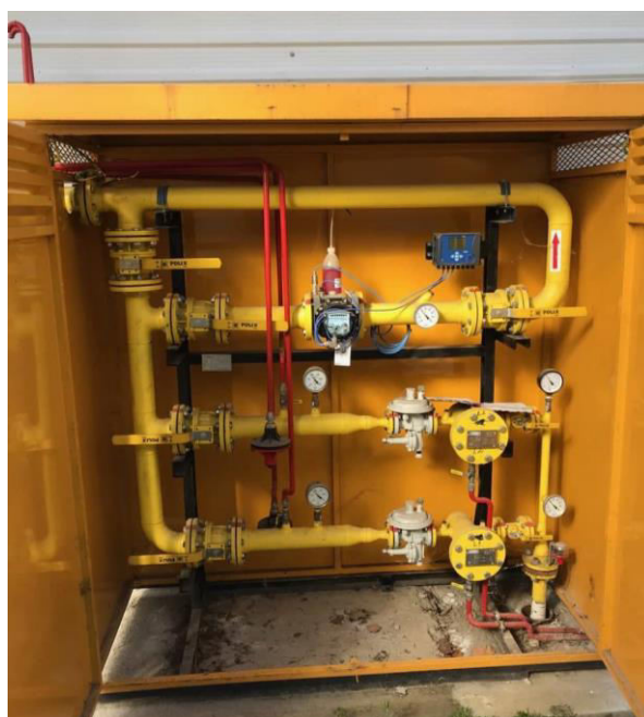
Слика 11. Изглед МРС G-160, максималног капацитета протока гаса Q_{\max} = 240 \text{ m}^3/\text{h} – Gasteh.
