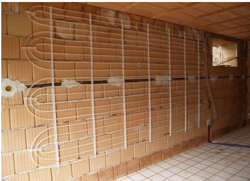
Слика 16. Изглед цевне инсталације зидног грејања [4]
