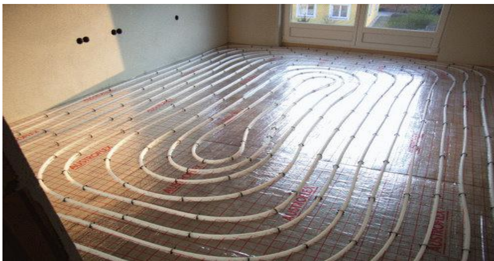
Слика 15. Изглед цевне инсталације подног грејања [4]
