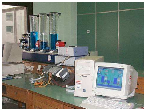
Слика 51. Илустрација једног лабораторијског DCS у SCADA система
