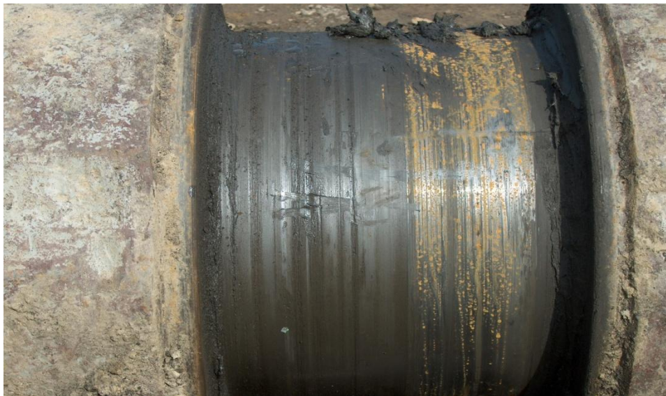
Слика 6- Оштећење на рукавцу погонског точка багера СРс-2000 услед лошег подмазивања
