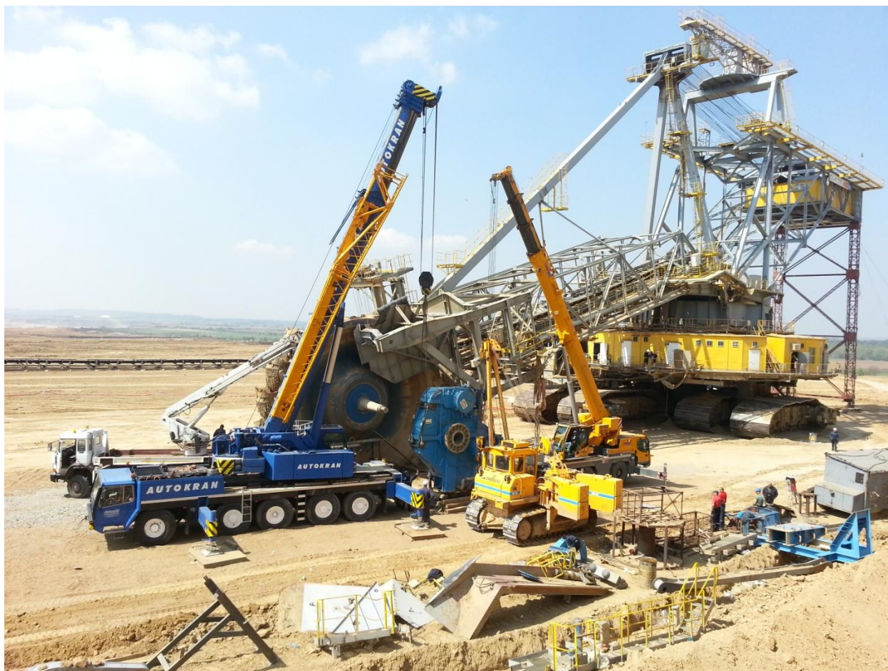
Слика 13-Приказ демонтаже редуктора радног точка са вратила
