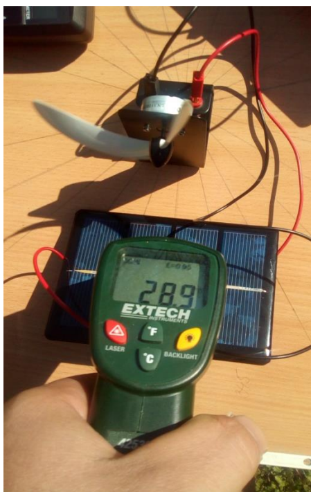
Слика 31.- Хлађење панела
