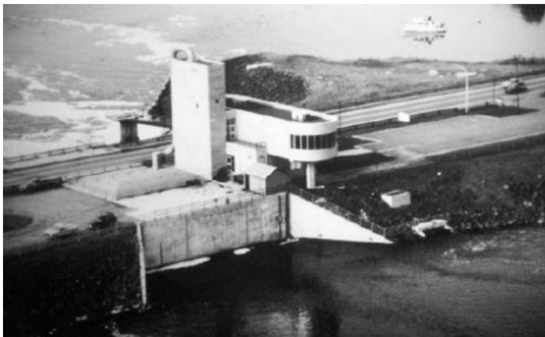
СЛИКА 19. Плимно постројење у Анаполис Ројал-у, Нова Шкотска, Канада. У првом плану је приказан улаз у собе постројења; у позадини је излаз у плимни базен.
