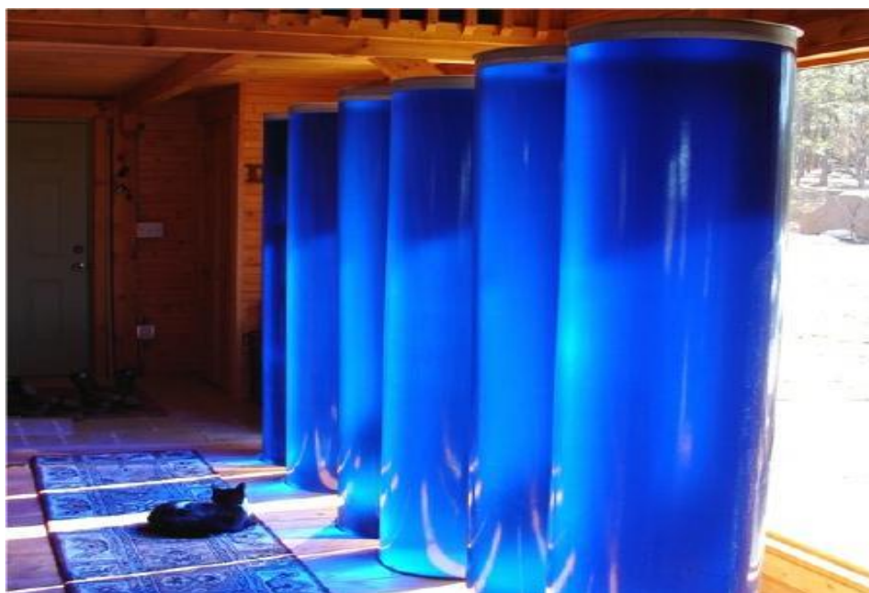
Слика 36. Пример воденог Тромбовог зида [17]
