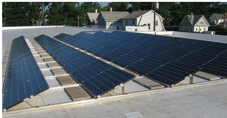
Слика 56. Соларни панели на равном крову [45]
