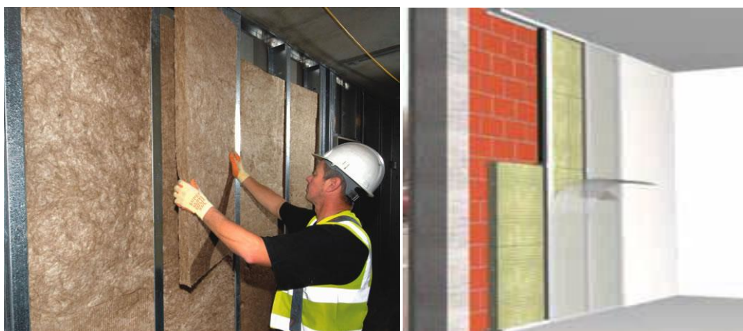
Слика 25. Изоловање спољашњег зида са унутрашње стране
