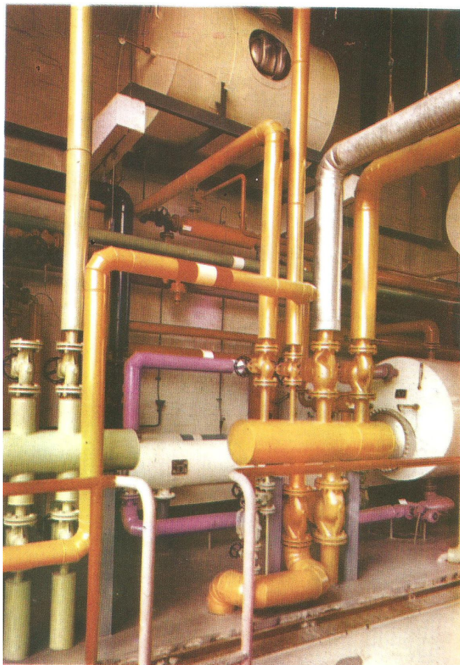
Слика 48. Приказ унутрашњих инсталација цеви бојених целом дужином [1]
