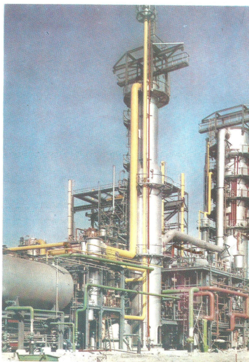
Слика 47. Изглед једне хемијске фабрике са обојеним цевима према врсти протока материје кроз цеви [1]
