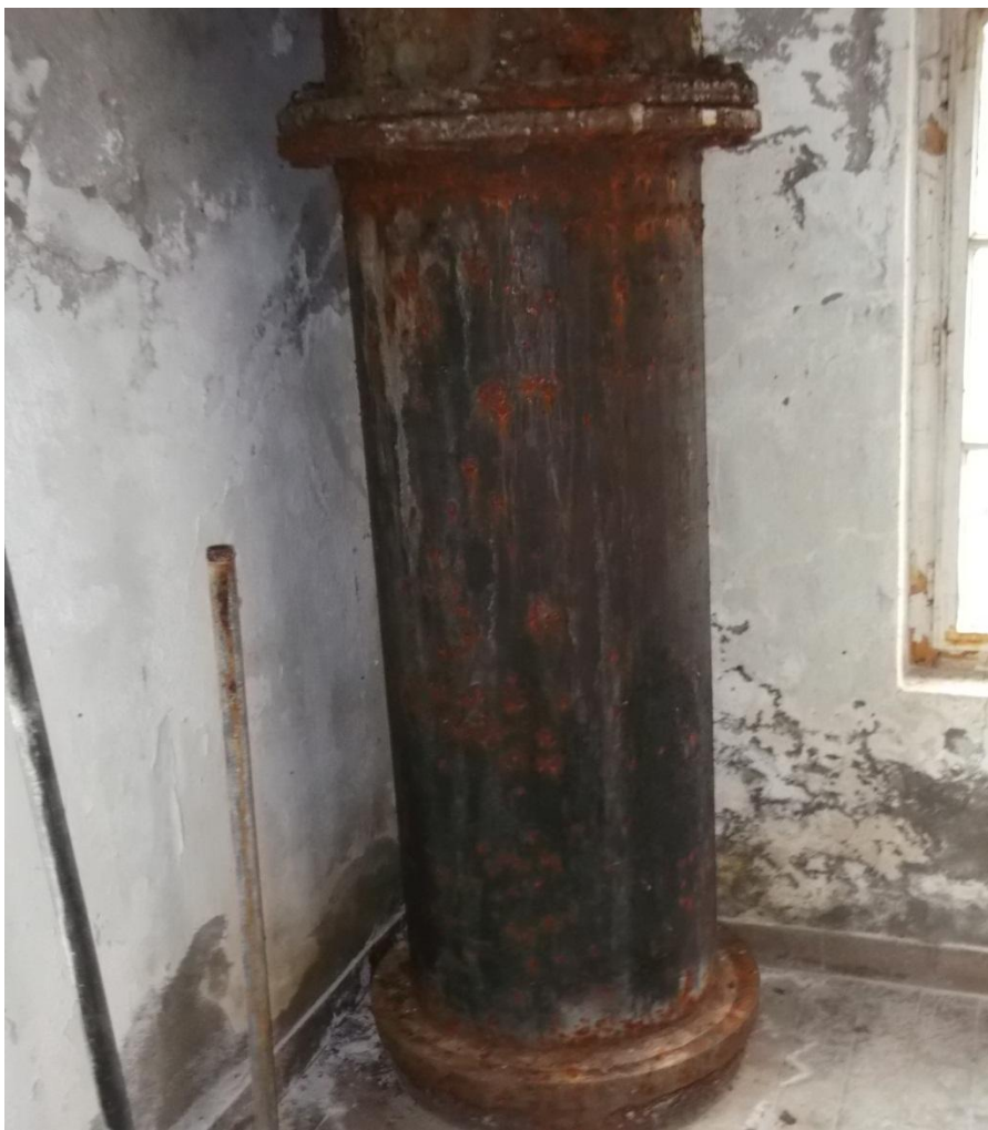
Слика 21 Део цевовода према филтерском постројењу у старој МХЕ Грошница (Ф700)
