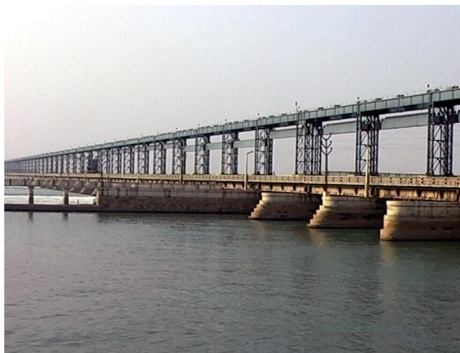
Слика 10 Koshi Barrage
