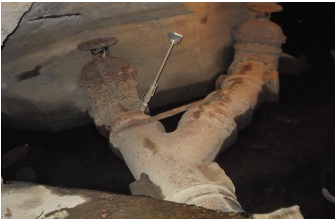
Слика 25 Рачва цевовода
