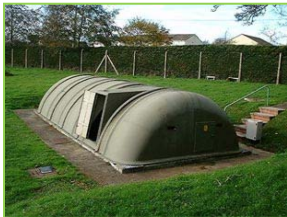
Слика 10.1. Типичан пример (RBC) јединице која се користи за третман отпадних вода [19]
