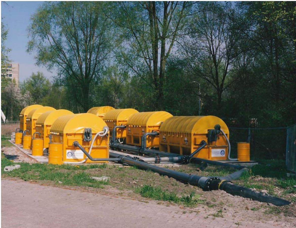
Слика 6.7. Више биодиск постројења повезаних на мрежу
