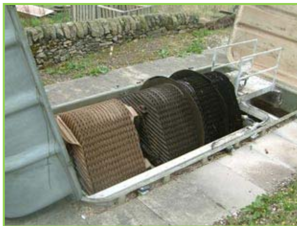
Слика 10.10. Промена боје дискова дуж вратила [19]
