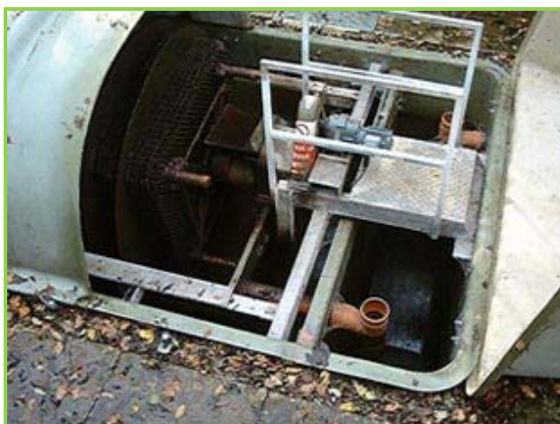
Слика 10.7. Хумус резервоар на крају RBC јединице [19]
