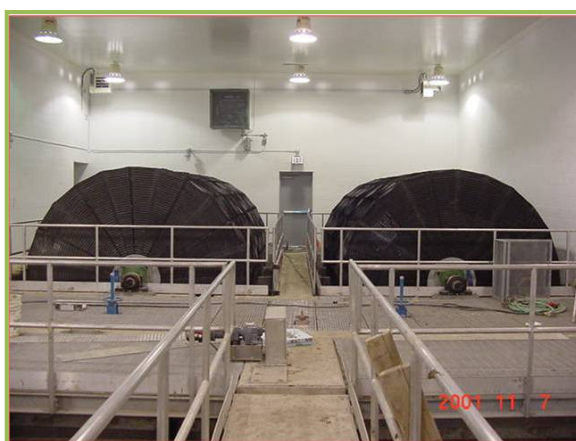
Слика 10.20. Унутрашњост постројења, постављеног у центар насеља, са две биодиск јединице. Amherstburg, Ontario, Canada [19]
