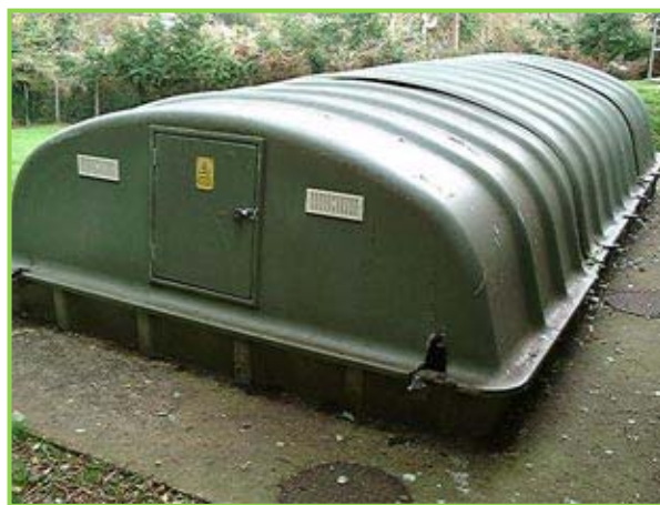
Слика 10.1. Типичан пример (RBC) јединице која се користи за третман отпадних вода [19]
