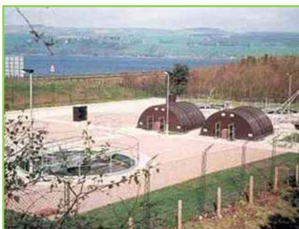
Слика 10.6. Две RBC јединице постављене заједно са сепараторима хумуса [19]
