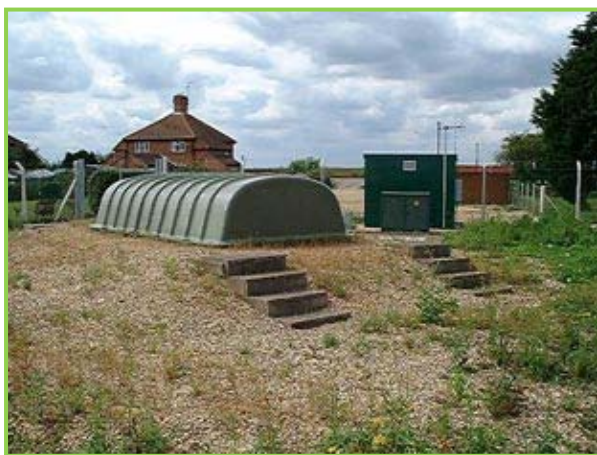
Слика 10.1. Типичан пример (RBC) јединице која се користи за третман отпадних вода [19]
