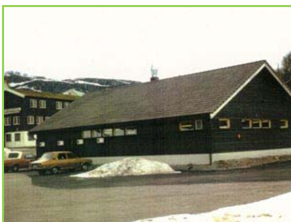
Слика 10.19. Изглед постројења постављеног у сред насеља [19]
