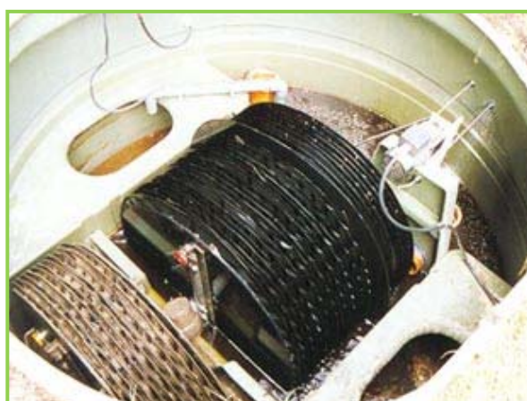
Слика 10.18. Унутрашњост модерне RBC јединице [19]
