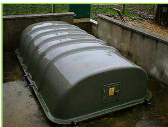
Слика 10.13. Компактна јединица, ограђена бетоном [19]
