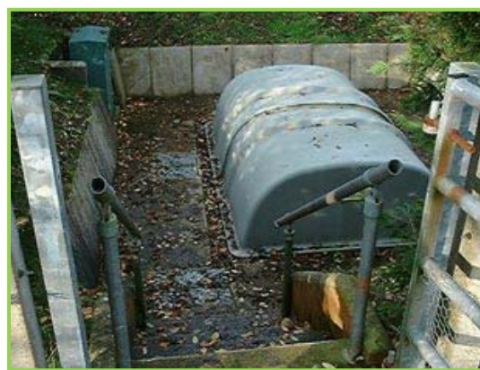
Слика 10.14. Укопано и бетоном заштићено постројење [19]
