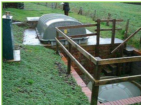
Слика 10.15. Биодиск са издвојеном хумус цистерном [19]
