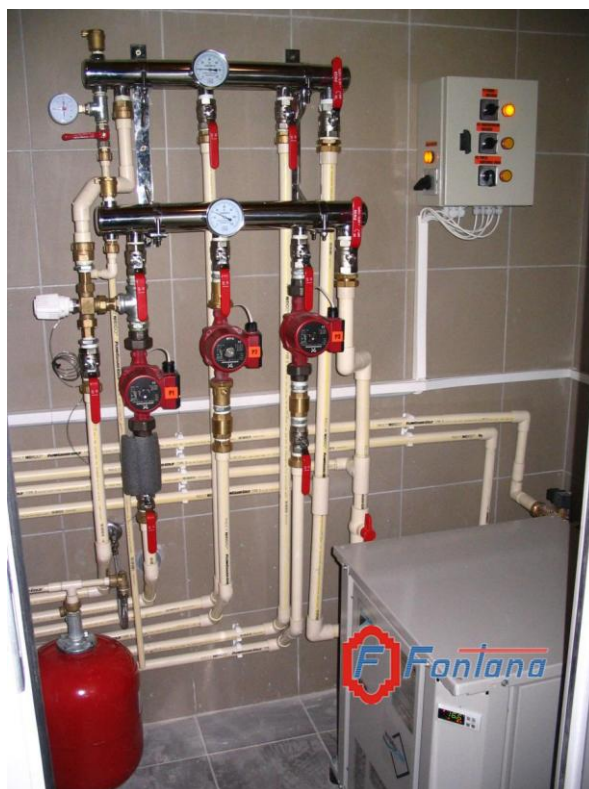
Слика 36. Приказ водоводне инсталације са ПВЦ-У цевима
