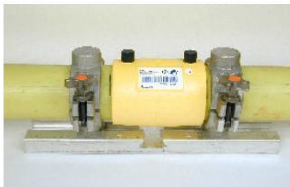
Слика 55. Постављање цеви у електричну спојницу
