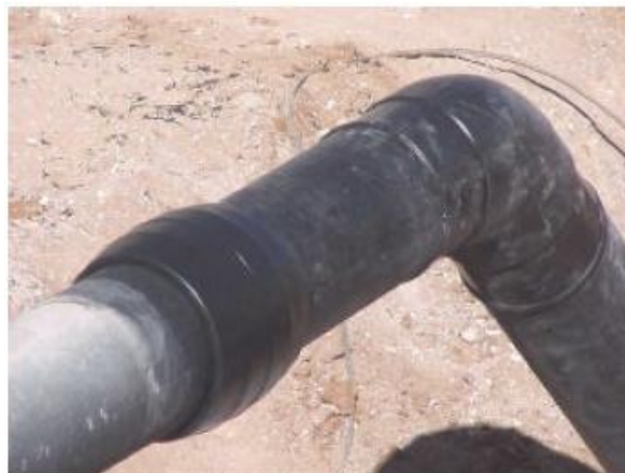
Слика 58. Изглед спајања цеви електричним фитингом [6]
