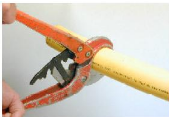
Слика 50. Сечење цеви ради добијања правилног облика цеви [6]
