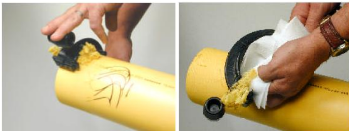
Слика 53. Процес стругања површине цеви [6]
