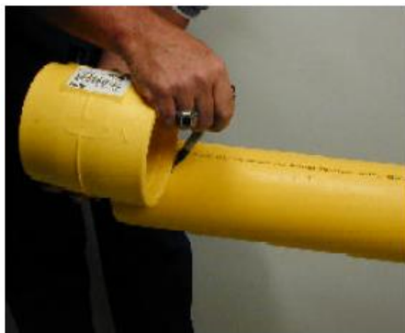
Слика 51. Обележавање простора на цеви који улази унутар спојнице
