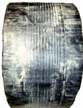
Слика 59. Приказ неправилно оствареног споја услед лоше очишћене спољашње површине цеви
