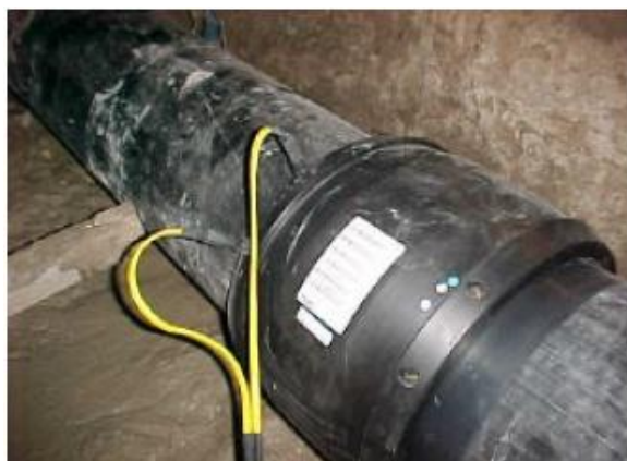
Слика 57. Прикључивање спојнице на напон
