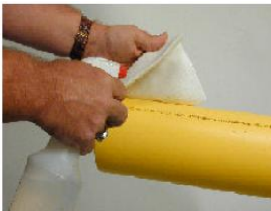
Слика 49. Поступак чишћења крајева цеви
