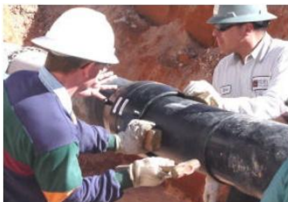
Слика 56. Позиционирање електричне спојнице
