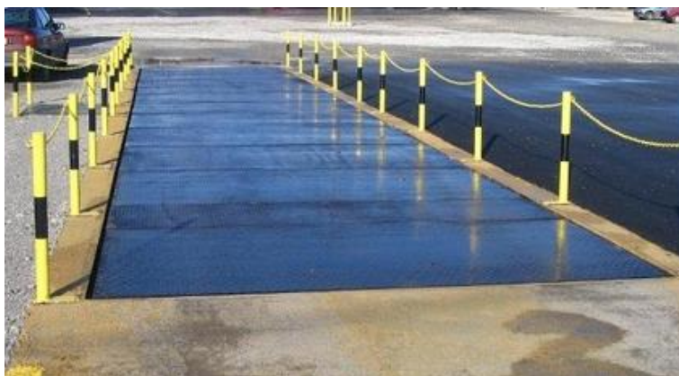
Слика 13. Колска вага са металним мостом у плиткој јами [12]
