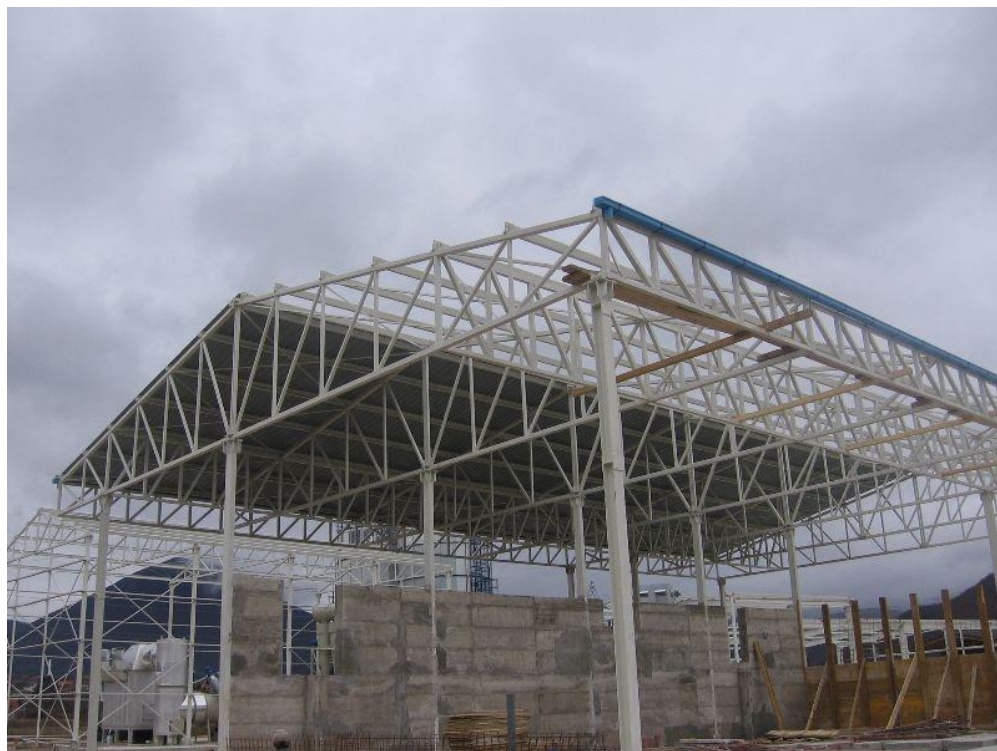
Слика 1.6. Индустријска хала у фази монтаже [5]
