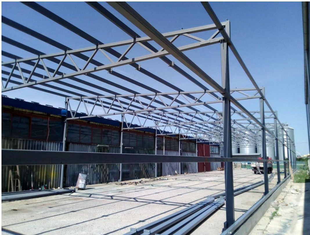
Слика 2.1. Монтажа индустријске хале
