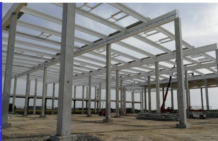
Слика 1.2. Комбиновање челика са бетоном [3]
