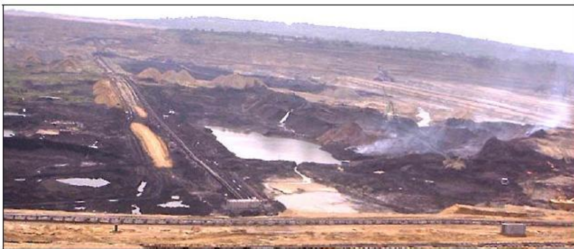
Слика 4.1. Изглед водосабирника VS-1
