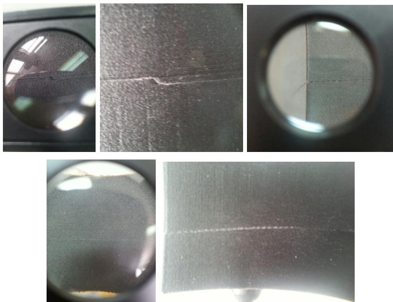
Слика 6.10 Визуелна провера линије спајања додирних површина
