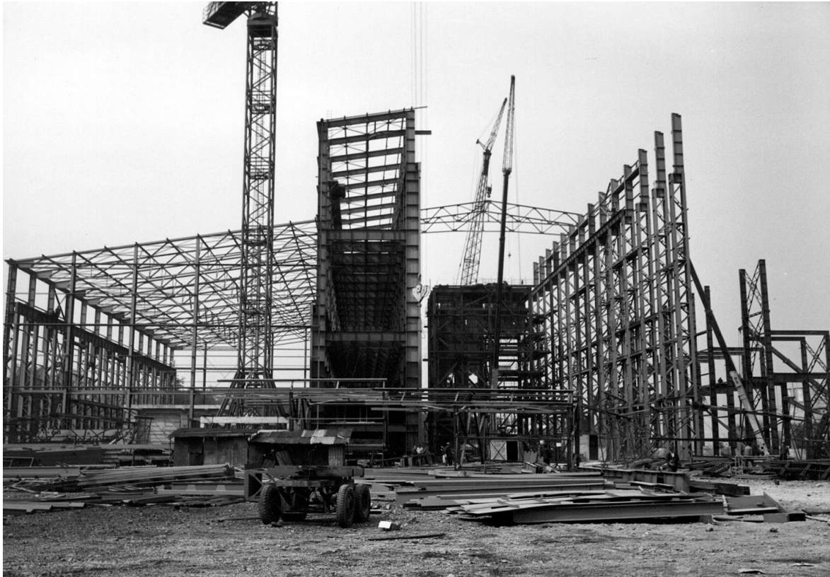
Слика 2.3 - Индустријска хала у фази монтаже
