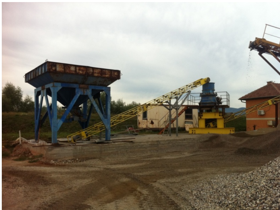
Слика 8.13. Коначан изглед монтиране конструкције тракастог транспортера [13]
