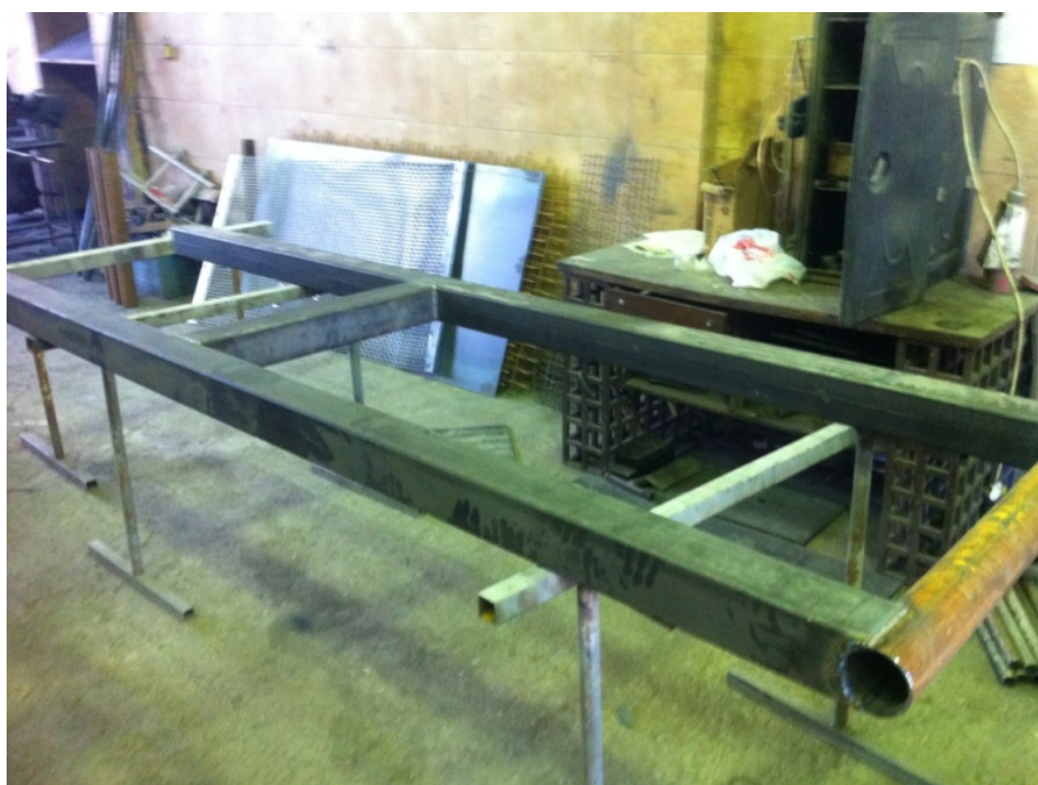
Слика 8.11. Израда носећих стубова конструкције тракастог транспортера [13]
