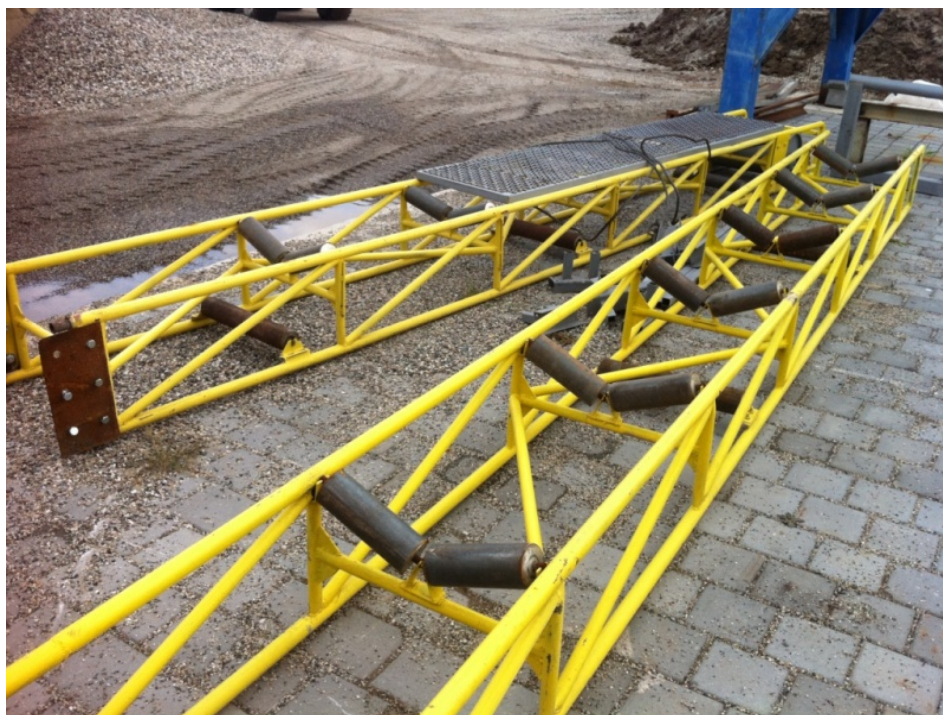
Слика 8.10. Конструкција тракастог транспортера на месту монтаже на сепарацији [13]
