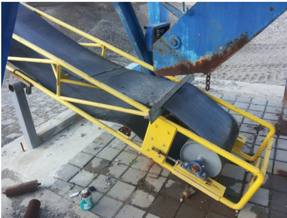
Слика 8.14. Монтажа и лепљење транспортне траке [13]
