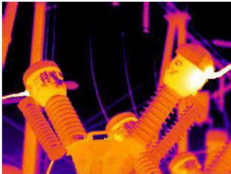
Слика 4.8 Прекомерно грејање у електроенергетском систему [8]
