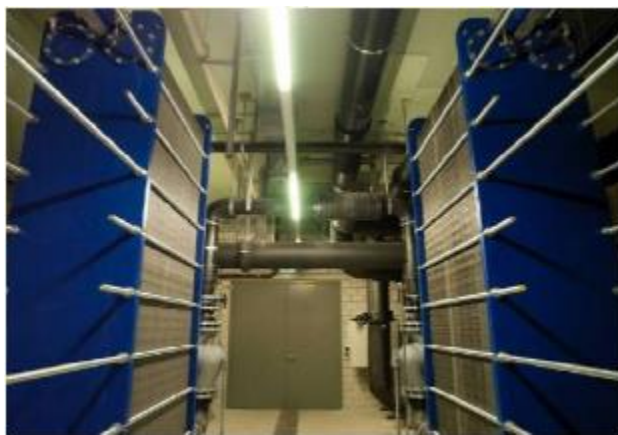
Слика 37. Плочасти размењивачи топлоте [9]
