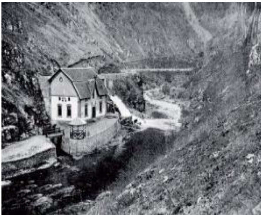
Слика 4 Хидроелектрана на реци Ћетињи [5]
