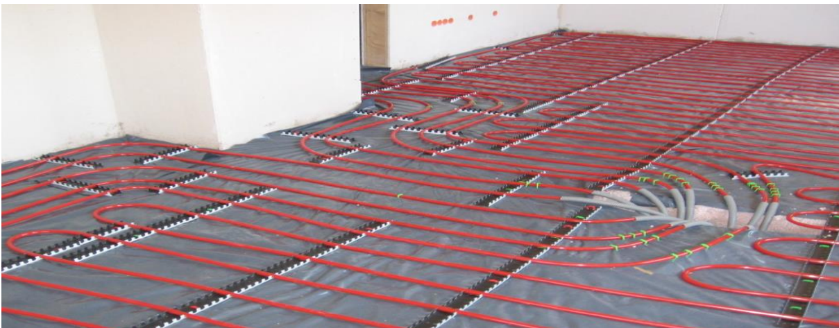
Слика 8. Цевни развод код подног грејања
