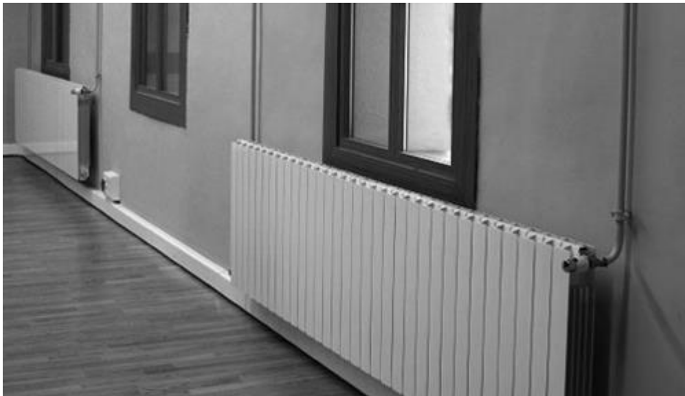
Слика 1. Пример инсталације централног грејања
