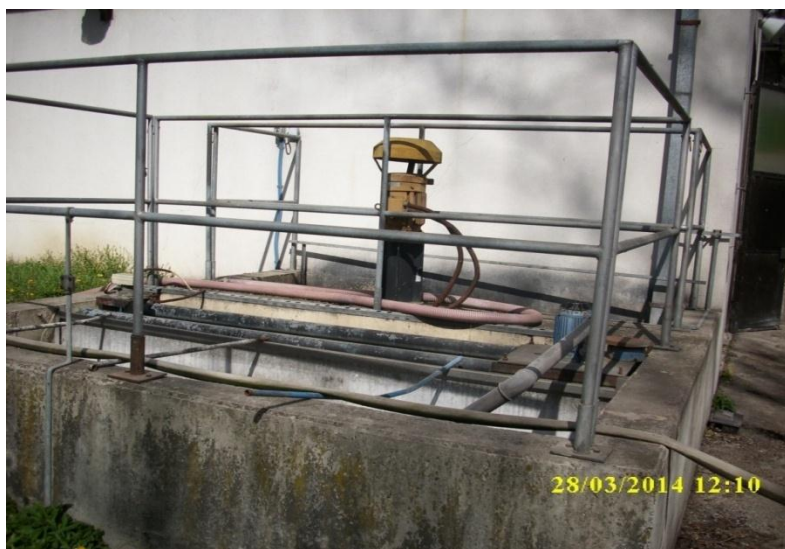
Слика 6.3 Базен за егализацију
