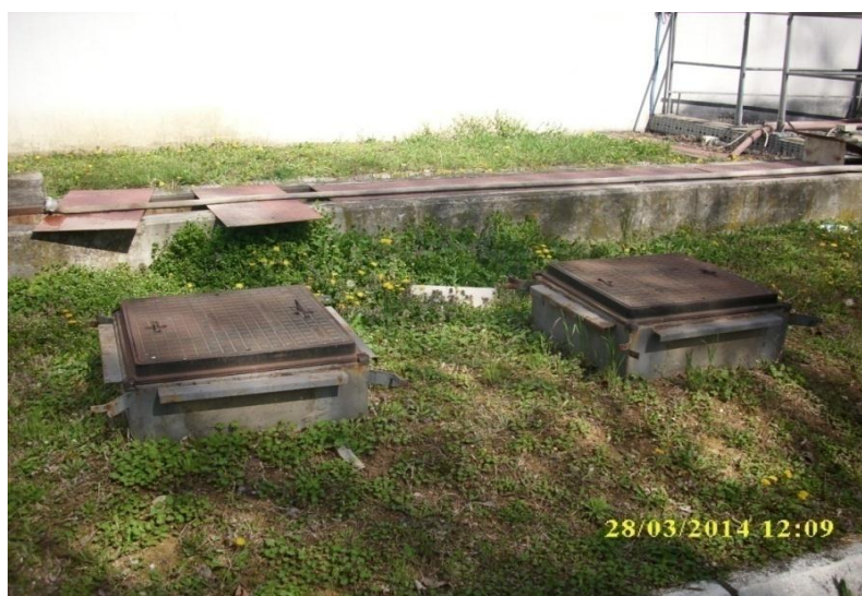
Слика 6.6 Ревизиони отвори сепаратора
