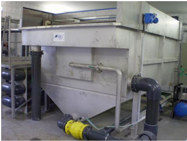
Слика 4.3 Постројење AS – FLOT технологије у млекари Хлинско која се налази у Чешкој
