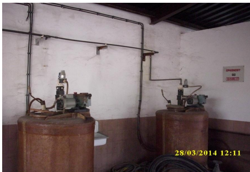
Слика 6.5 Инсталација за припрему и дозирање хемикалија
