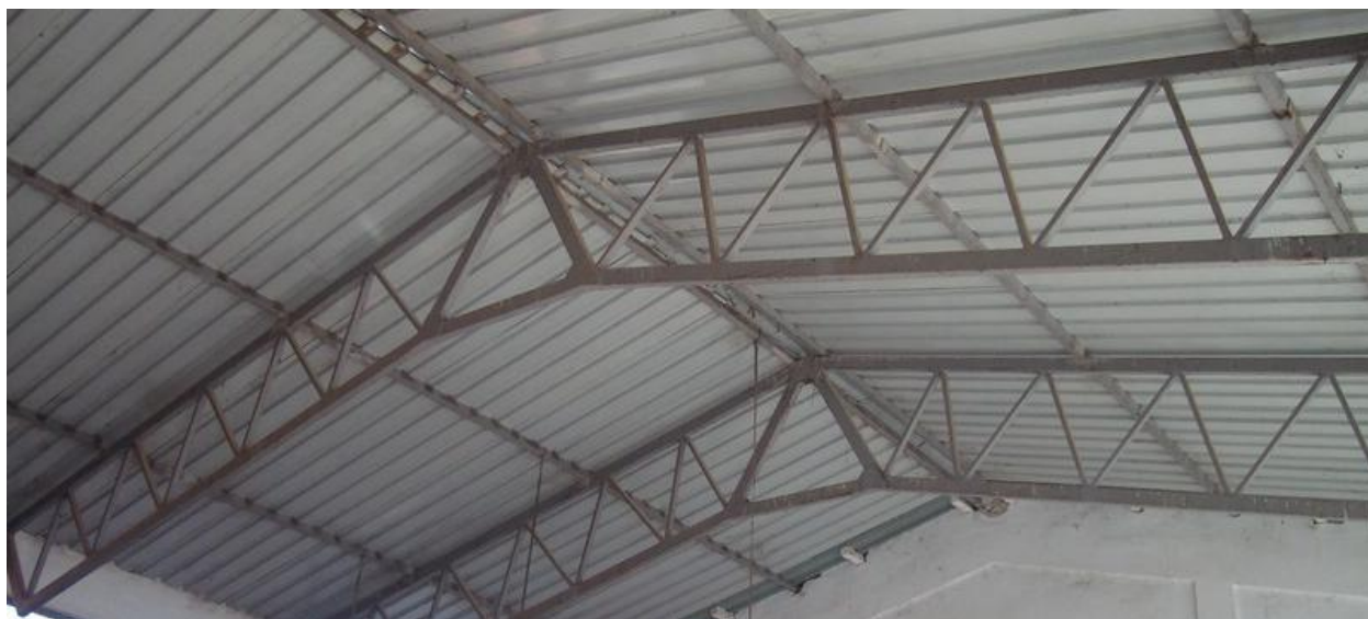
Слика 1.4 – Пример решеткастог носача (кровна конструкција)
