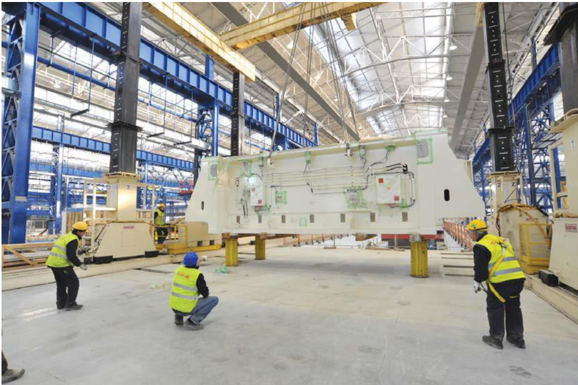
Слика 1.1 – Пример решеткастих и лимених носача (фабричка хала са мостном дизалицом)
