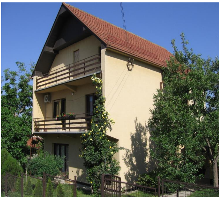
Слика 8. Југоисточна фасада објекта
