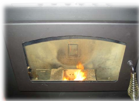
Слика 4.5 Комора за сагоревање
