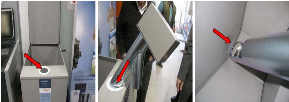
а б в Слика 5.4 монтирање пужног преносника и резервоара за пелете
