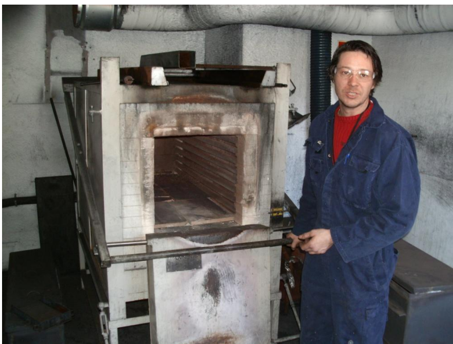
Слика 52. Топлотна пећ за индустријске сврхе
