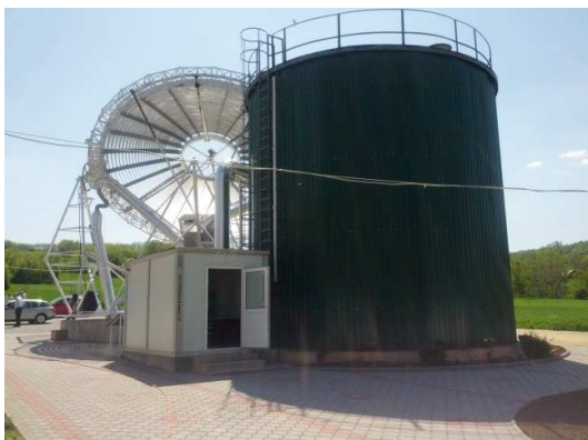
Слика 6.11 Соларна електрана капацитета 50 kW са посебним акумулатором за складиштење топлотне енергије у Бадњевцу [36]
