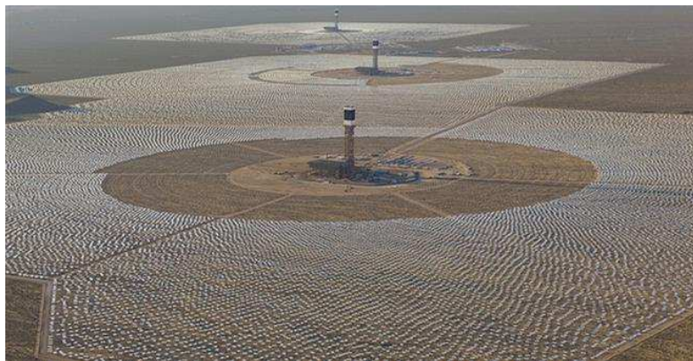
Слика 6.23 Приказ соларне електране [43]
