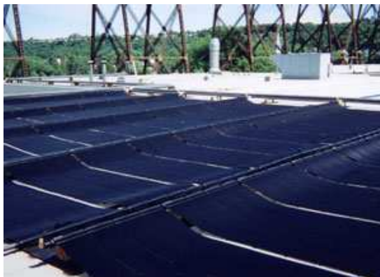
Слика 4.3 Незастакљени равни водени непокретни соларни колектори [5] [14]
