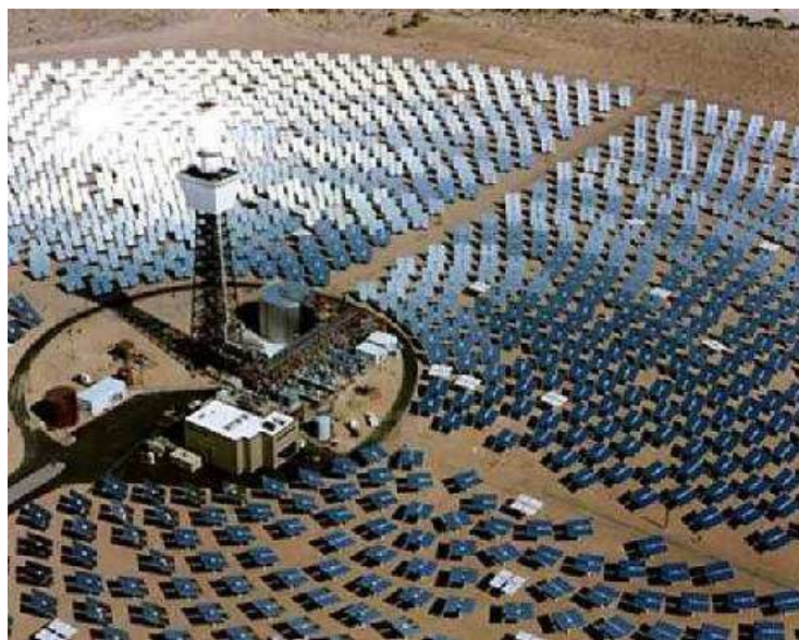
Слика 4.19 Централни пријемник са пољем хелиостата [5] [14]
