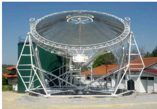
Слика 6.11 Соларна електрана капацитета 50 kW са посебним акумулатором за складиштење топлотне енергије у Бадњевцу [36]
