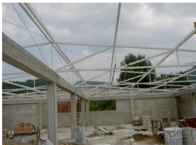
Слика 1.3: Комбиновање челика са бетоном [2]
