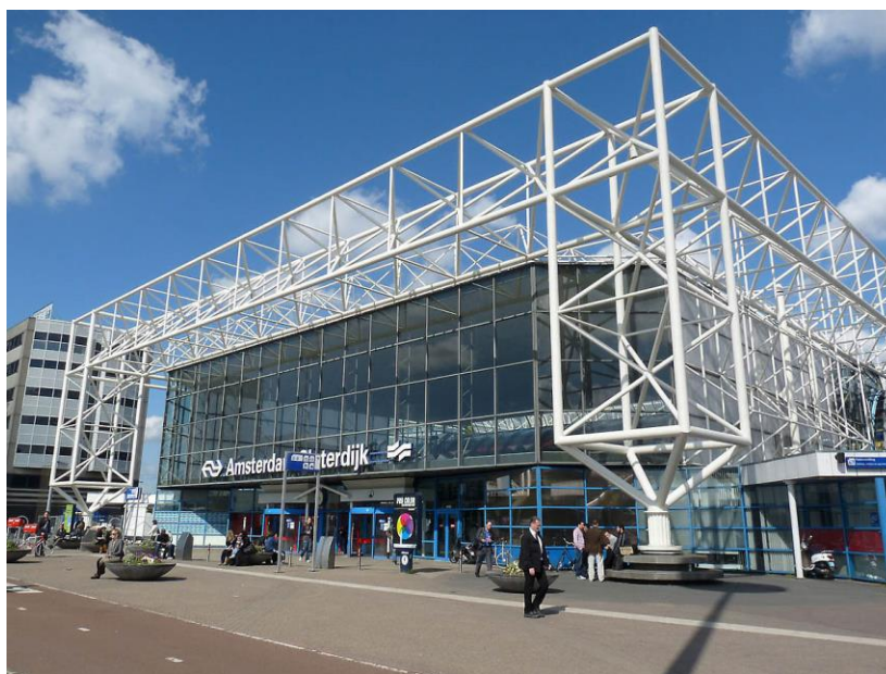
Слика 3.28: Примена решеткастих носача од шупљих профила [10]
