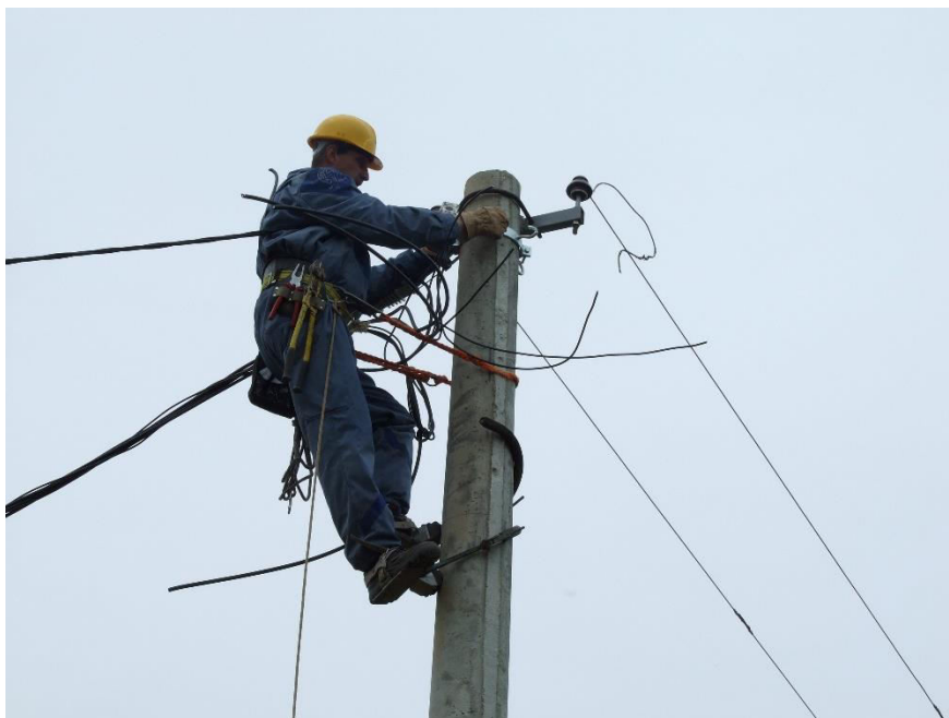
Слика 3.5 Радник на радном месту са опремом: заштитни шлем, заштитно одело летње, заштитне рукавице, ципеле заштитне плитке, злектромонтерски заштитни опасач [3]
