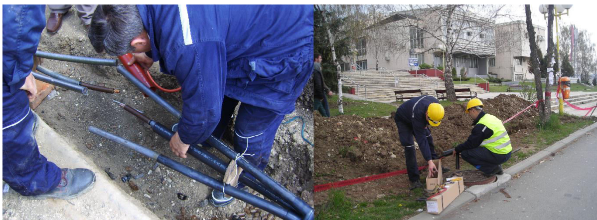
Слика 3.4 Рад на кабловским водовима 110 и 35 kV [3]
