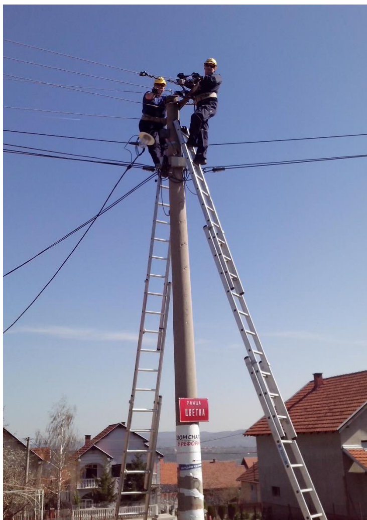
Слика 3.5 Рад на ваздушним водовима 110 и 35 kV [3]
