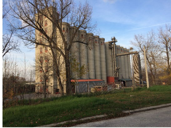
Слика 30. Изглед силоса са помоћним објектима
