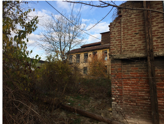
Слика 24. Напуштени објекти
