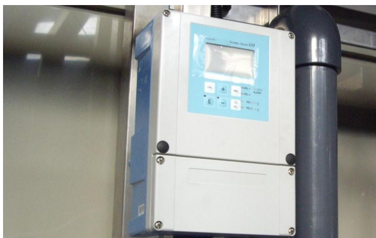
Слика 45 – Уређај за контролу pH вредности
