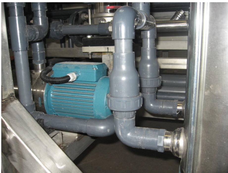
Слика 37 - Пумпа за прање УФ модула
