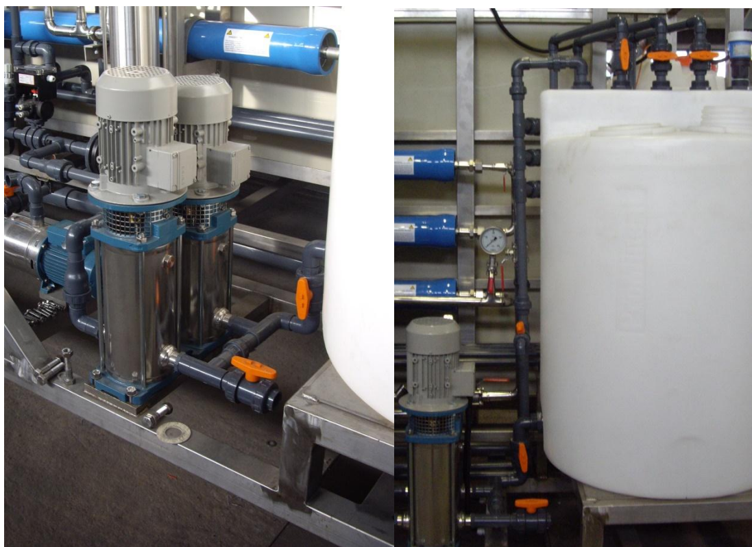
Слика 49 – Резервоар за прање (CIP) и пумпе за прање система
