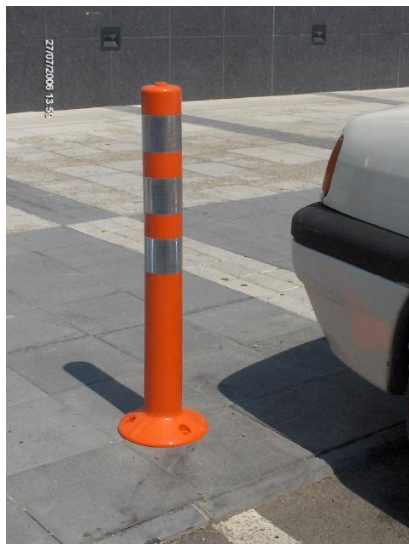
Слика 28 – Изглед флексибилног стубића са рефлектујућим тракама
