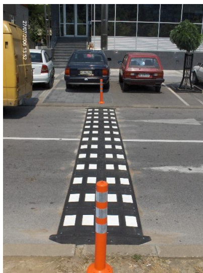
Слика 23 – Изглед лежећег полицајца са постављеним (флексибилним) еластичним стубићима
