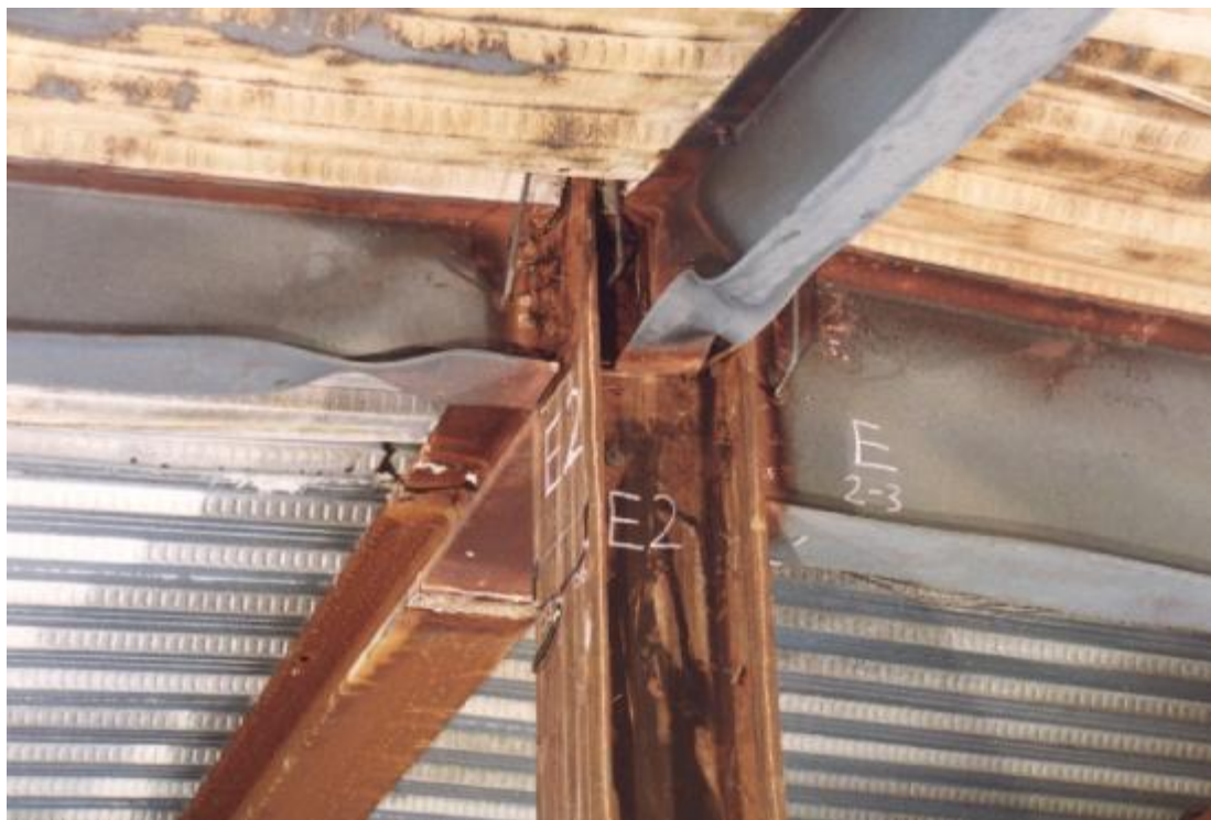
Слика 2.4 Пример лоше конструкције израђене од стандардних профила
