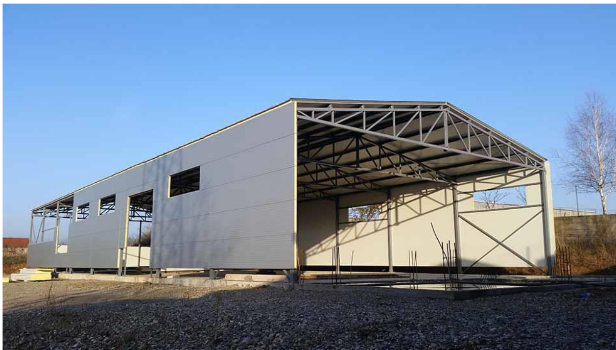
Слика 2.5 Приказ монтажне хале израђене од стандардних профила
