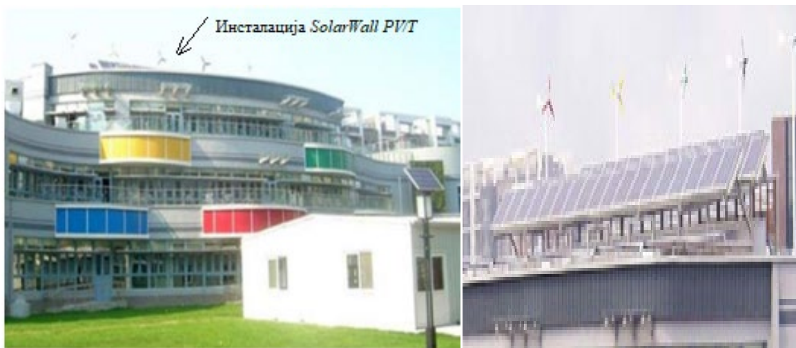
Слика 6.3.3.6. Инсталација SolarWall PV/T у олимпијском селу у Пекингу [17][26]
