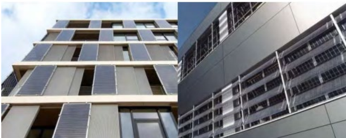
Слика 6.3.3.2. Колектор за хлађење BIPV/T система [26]
