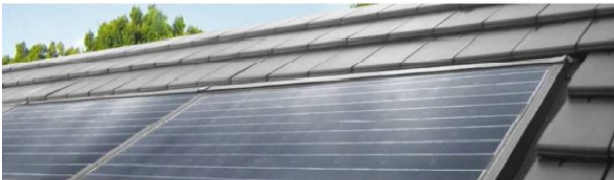
Слика 6.3.1.3. Соларни систем као модул за спољну завршну обраду крова зграде [29]
