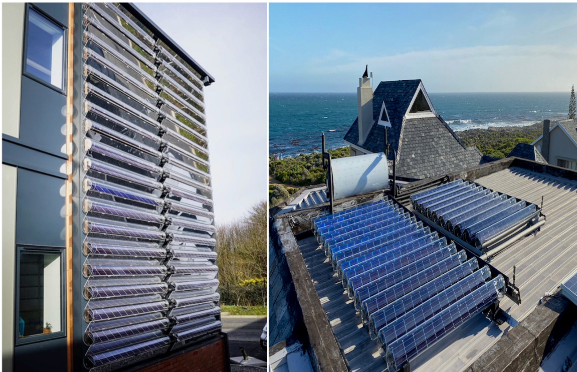
Слика 6.3.3.10. Имплементација Virtu хибридног PV/T пријемника у зградарству [26][33]
