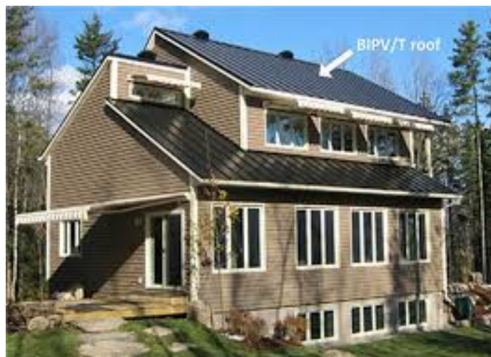
Слика 6.3.1.2. Кровна имплементација хибридног соларног пријемника [29]
