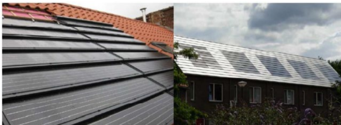
Слика 6.3.1.4. Соларне ћелије као алтернатива традиционалним завршним материјалима у косим ојачаним модулима [29]
