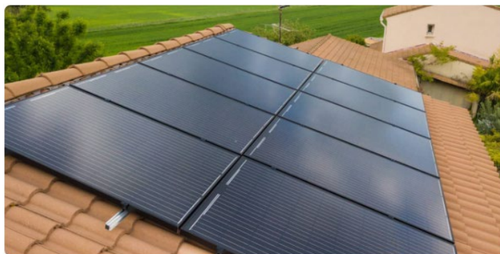
Слика 6.3.3.7. Кровни интегрисани хибридни PV/T пријемници у Марсеју у јужној Француској [26]
