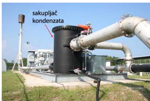
Слика 21. Сакупљач кондензата
