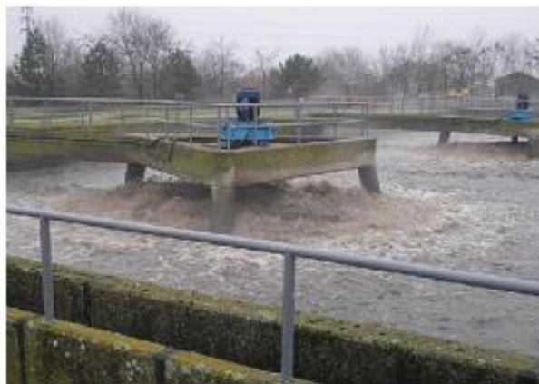
Слика 6. Аерациони базен
