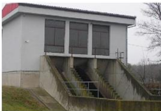
Слика 9. Црпна станица за рецикулацију муља
