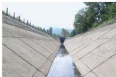
Слика 22. а) природно призматично корито канала б) вештачко призматично корито канала
