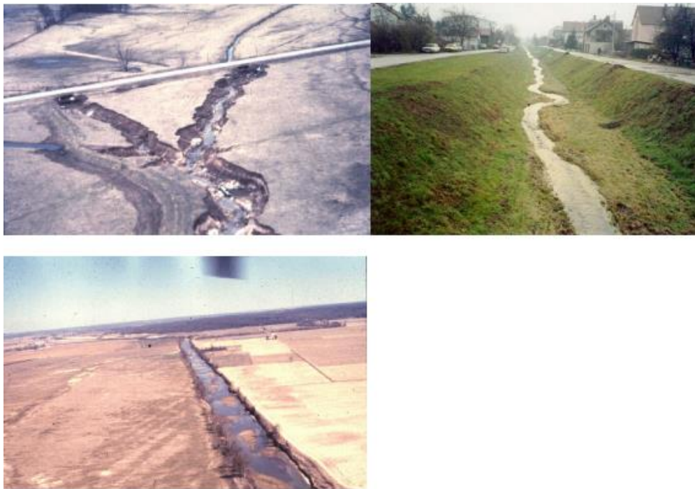
Слика 15. Одговор водотока на непримерена техничка решења
