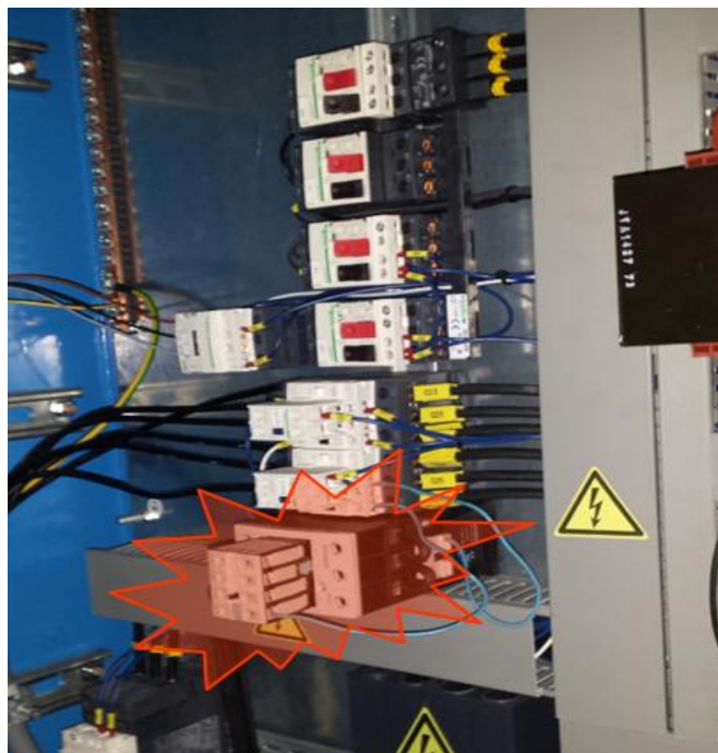
Слика 7.4 Проблематични контактор
