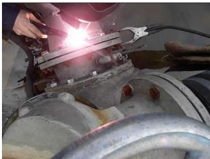
Слика 4.6 Пример извођења заваривања прирубнице [8]
