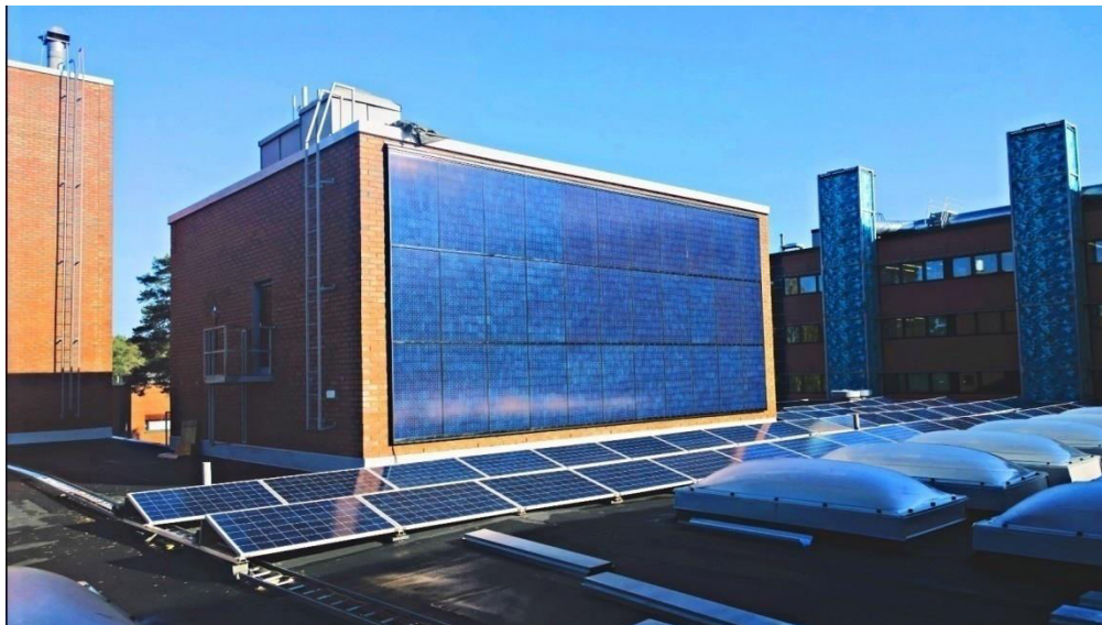
Слика 50. Монтирање панела на спољашње зидове и фасаде објекта 2 [44]
