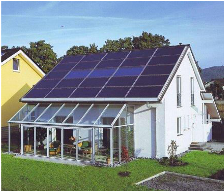
Слика 48. Постављање ФН система на коси кров објекта [42]
