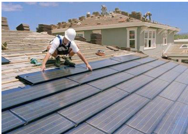
Слика 27. Постављање ФН система[18]
