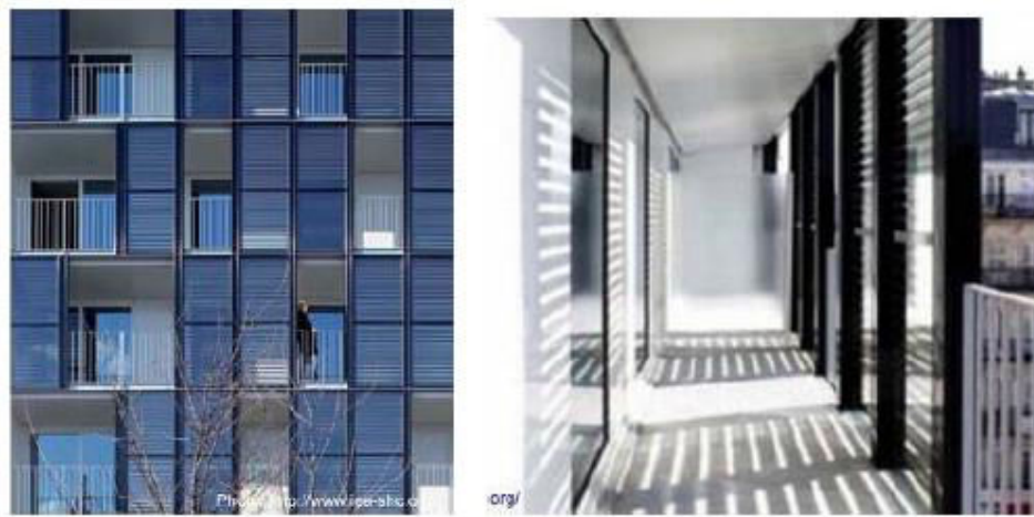
Слика 59. Полутранспарентни колектори уграђени у двоструки омотач зграде
