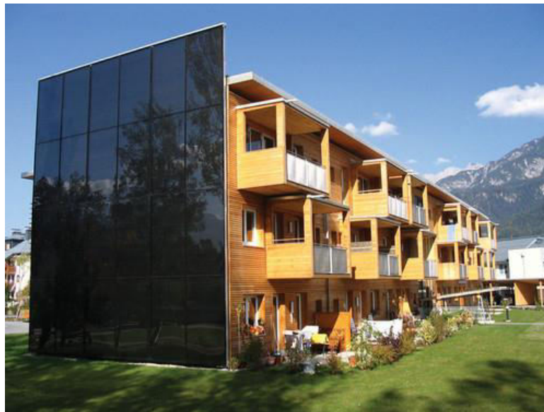
Слика 57. Фасадни колектори на згради [50]
